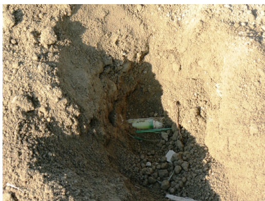
Foto 3 - Particolare del fusto di canna interrato a una profondità compresa tra 200 e 250 mm.
