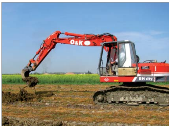
Foto 2 - Escavatore O&K RH.
